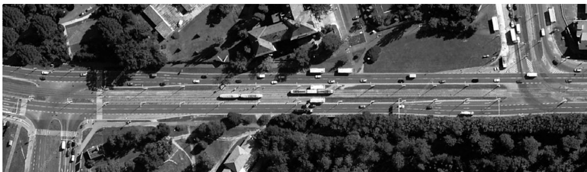
Snímek z ortofotomapy nám dokumentuje stav zastávkového prostoru Lékařská fakulta, Karlovarská před rekonstrukcí. Koleje leží uprostřed čtyřpruhové komunikace, lemují je travnaté pásy a na obou koncích nalezneme tři řadící pruhy před SSZ.
