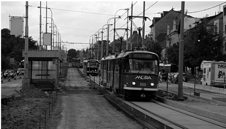
Extrémní čtyřminutové pevné cykly zabezpečovaly provoz na jednokolejné trati. Délka volna umožňovala bezproblémový provoz pouze dvou souprav. Nebylo však výjimkou potkat tři vlaky v následu. Na jaký signál jede poslední třetí vlak si čtenář odpoví sám. Fotografie zachycuje zastávku Pod Záhorskem ve směru z centra s již nově položenou kolejí ve velkoplošných panelech a zlikvidovaným výstupem z podchodu. V místě chybějící koleje jsou patrné stopy po podkladnicích v betonové desce. Foto © autor.
