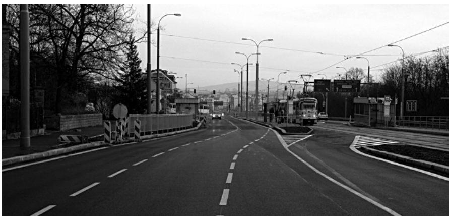
Pohled na rozřazovací pruhy před křižovatkou s ulicí Na Chmelnici. Výjezd ze sdružené zastávky je přesně v místě rozšíření ze dvou jízdních pruhů na čtyři, nehledě na jeho nedostatečnou šířku (pozůstatky navrženého vodorovného značení vzniklého při stavbě lze ze snímku ještě spatřit) a hlavně ostré hrany obrubníků v pravé části snímku. Pomyslnou třešničkou na dortu jsou řidiči nerespektující vodorovné dopravní značení. Navrzení obdobného řešení v zápočtové práci na fakultě by jistě znamenalo brzký konec snahy získat ze zmíněného předmětu zkoušku. Foto © autor.
