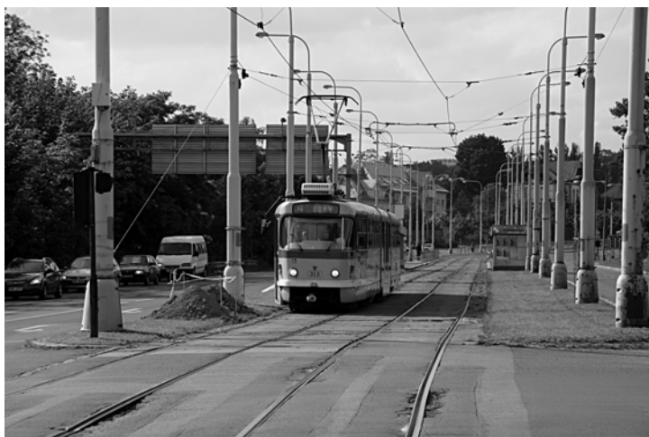
Archivní snímek zachycuje stav zastávkového prostoru Lékařská fakulta, Karlovarská před rekonstrukcí v pohledu z centra. Notně ojeté a směrově i výškově neurovnané kolejnice NT1 zakryté základňovými panely uprostřed čtyřpruhové komunikace se třemi řadícími pruhy na křižovatce.
