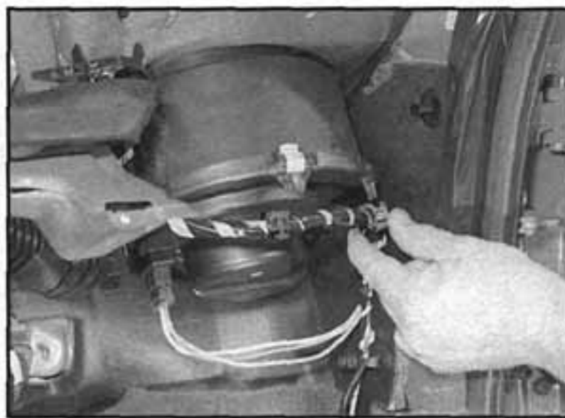
9.23a Uvolníme kabelový svazek ze svorek na spodní straně krytu ventilátoru...
